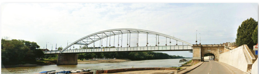
Die Belvárosi-Brücke in Szeged bei normalem Wasserstand der Theiß
